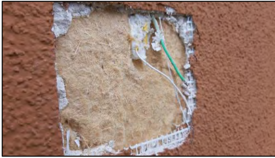
Abbildung 44: Geöffnete Messposition P an der Variante N 2.6 (dunkler Putz) nach dem Messzeitraum. Optisch ist kein Pilzmyzel erkennbar.
