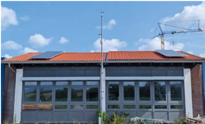
Abbildung 1: Testgebäude im Fraunhofer Instituts für Bauphysik in Holzkirchen zur Untersuchung des Einflusses von PV-Anlagen bei unterschiedlichen Dachkonstruktionen.
