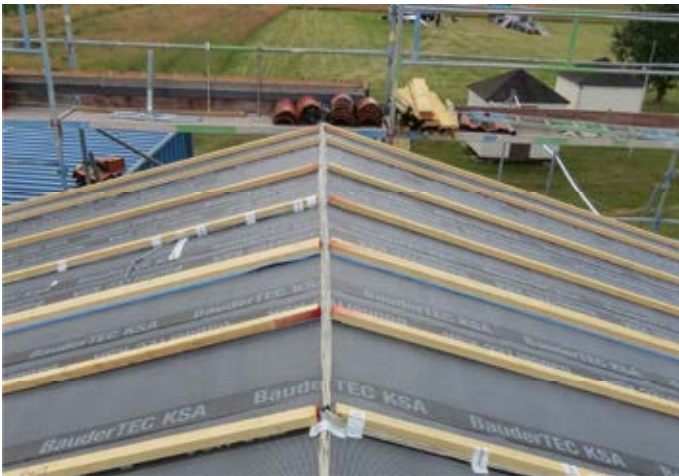
Abbildung 3: Varianten während des Versuchsaufbaus 2023. Links: Variante A mit fertig verlegter diffusions-sperrender Unterdachbahn, Konterlattung und Temperaturfühlern. Rechts: Variante B: Verlegung der Vario KM Supraplex – SKS auf der Holzschalung, rechte Dachhälfte: fertig verlegte Aufsparrendämmung mit aufkaschierter Unterdeckbahn ULTIMATE AP SupraPlus.
