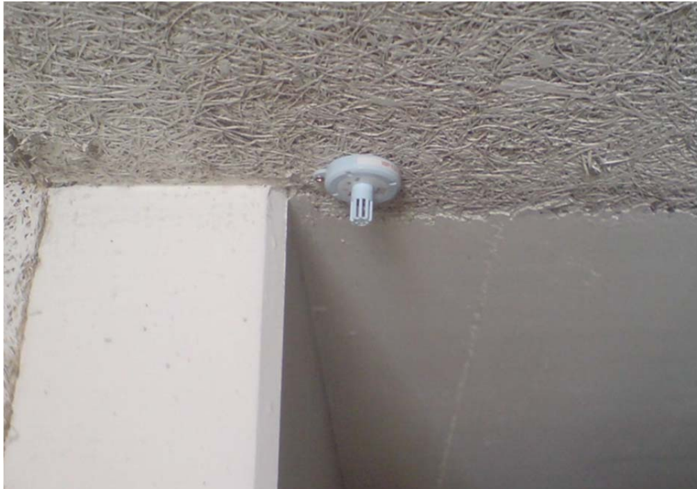
Bild 407: Darstellung des Messfühlers, der sich in der Mitte der Rampe in der Tiefgarage 2 befindet.
