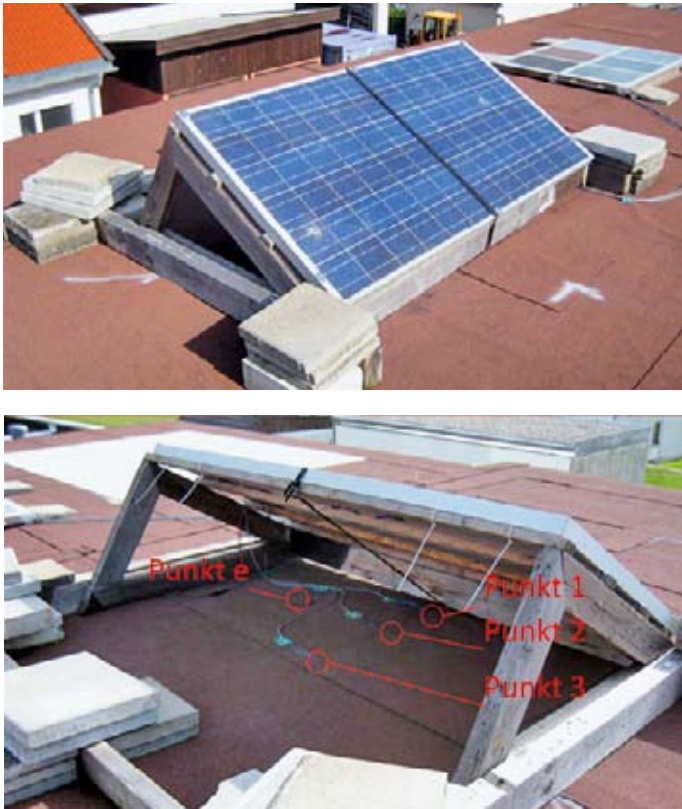
Abb. 2: oben: Versuchsaufbau zur Temperaturmessung unter einem nach Süden orientierten Solarpanel; 30° zur Horizontalen geneigt. unten: Blick unter das PV-Modul, für die Auswertungen wurde nur die kritische Position an Punkt 2 mittig unter dem Modul verwendet.
