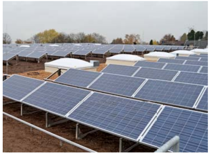
Abb. 1: Holz-Flachdach mit aufgeständerter PV-Anlage.
