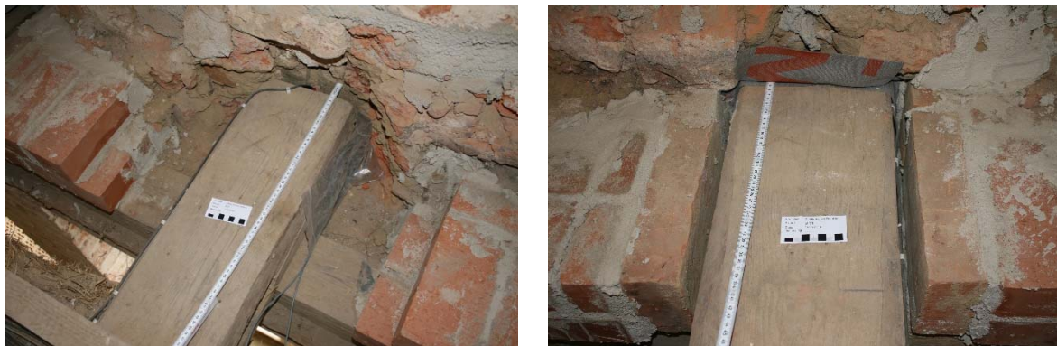
Abb. 2 Balkenaufleger auf einer Mauerlatte in einer Außenwand aus Vollziegelmauerwerk.
