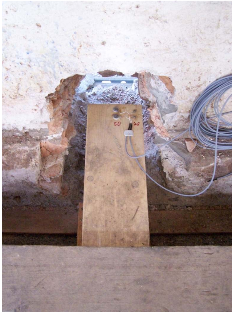
Abb. 37 Einbau der Holzfeuchtefühler für die Erfassung der oberflächennahen Feuchte (hier mit 48 nummeriert) und der Kernfeuchte des Balkenkopfes (Nr. 50).
