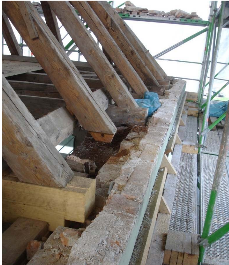
Abb. 40 Ansicht der Balkenköpfe nach Abdeckung des Daches auf der Nordseite. Hier sind bereits einige Holzbalkenköpfe saniert.
