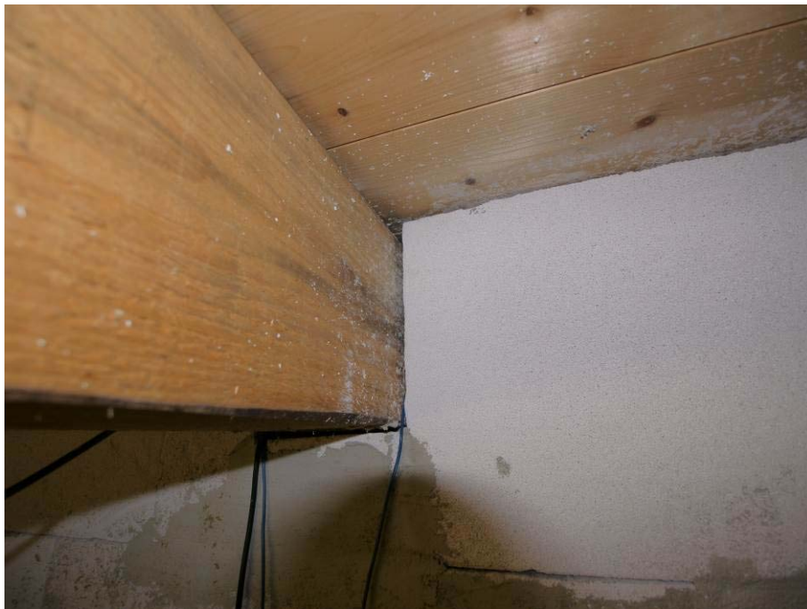
Abb. 75 Ansicht der Ausführung des Balkens 4 im Raum 1 mit „2 mm Fuge“; analog wurde im Raum 2 der Balken 2 ausgeführt.
