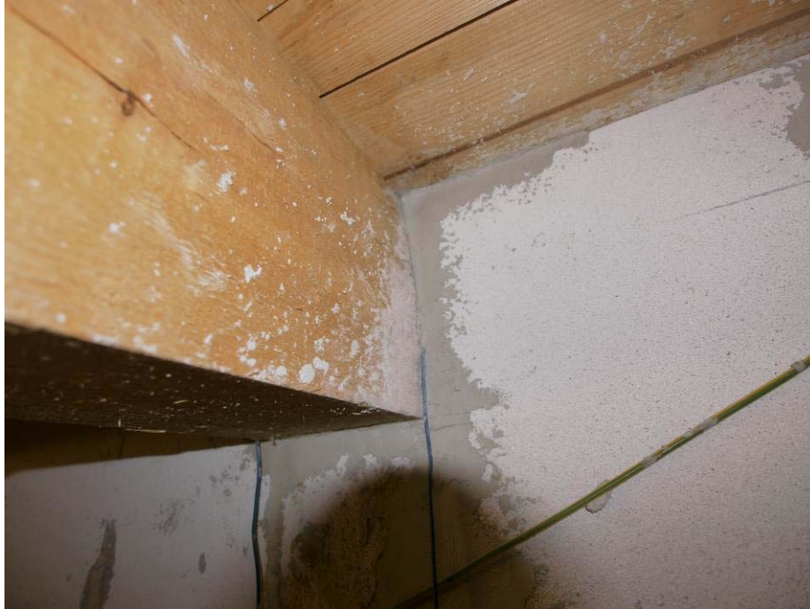
Abb. 78 Ansicht der Ausführung des Balkens 6 im Raum 1 mit Baukleber „abgedichtet“.
