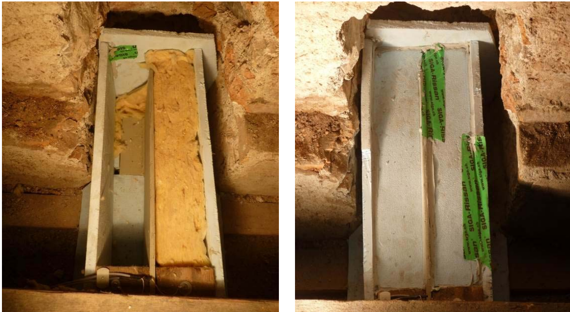
Abb. 29 Aufbau einer Box um das Schlitzblech der Variante 2 herum, die dann mit Mineralwolle gefüllt (links) und anschließend verschlossen wird (rechts).
