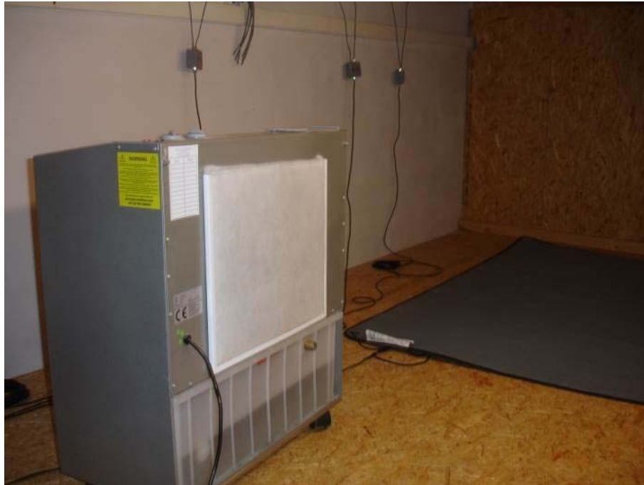
Abb. 81 Blick in einen der beiden Messräume. Links im Vordergrund ist der Raumluftbefeuchter zu sehen. Rechts davon liegt die Heizmatte zur Temperierung des Raumes.
