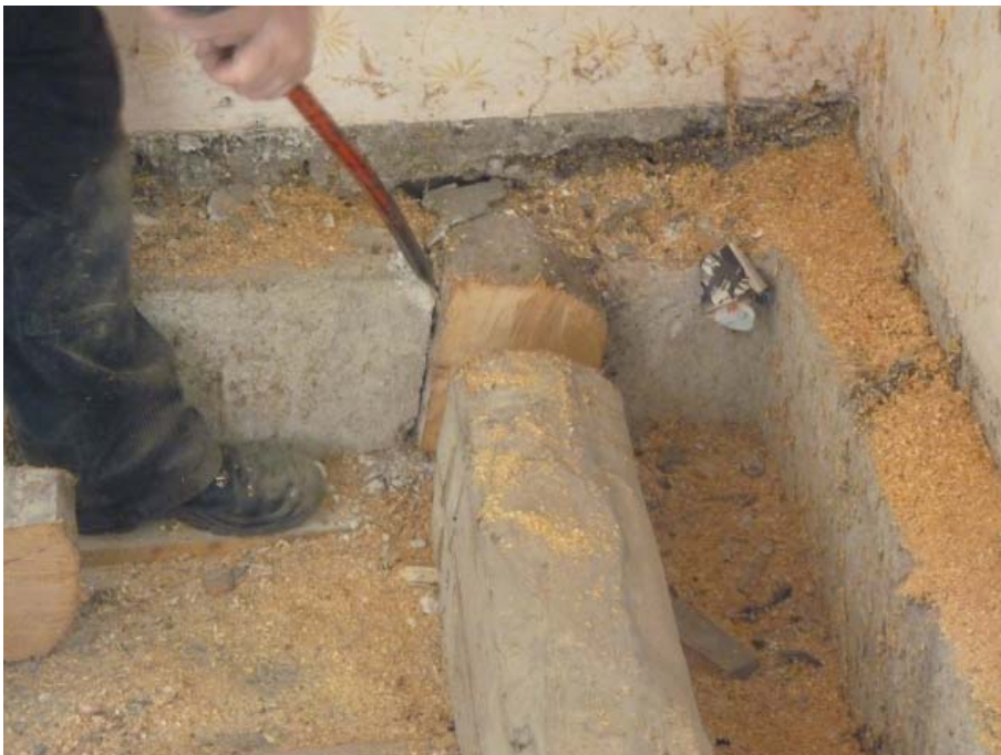
Abb. 24 Beispielhafter Ausbau des Holzbalkenkopfes.
