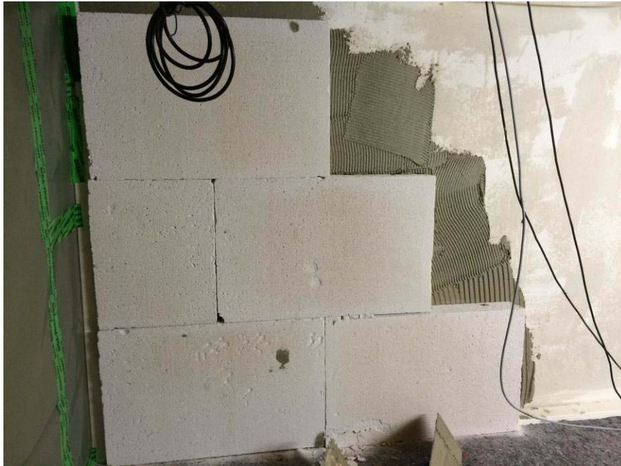
Abb. 82 Beginn des Einbaus der Innendämmung aus 8 cm starken Mineralschaumplatten (WLG 040) in Raum 1 Anfang Oktober 2014.
