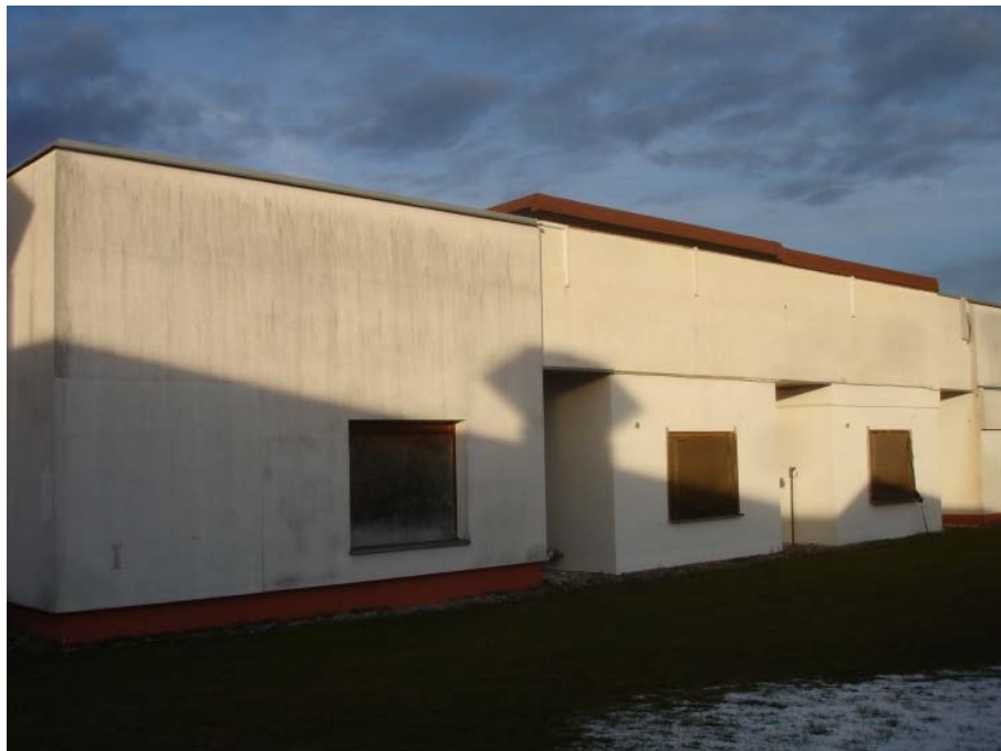
Abb. 66 SW-Ansicht des Versuchsgebäudes im Freigelände des Fraunhofer-Institutes für Bauphysik in Holzkirchen mit Flachdachelement auf der Attika des Flachdaches.
