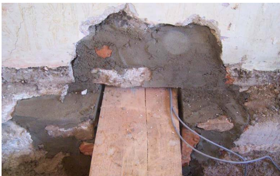
Abb. 27 Variante 1b mit Überblattung, Mörtelbett als Auflager aber ohne umseitige Dämmung.
