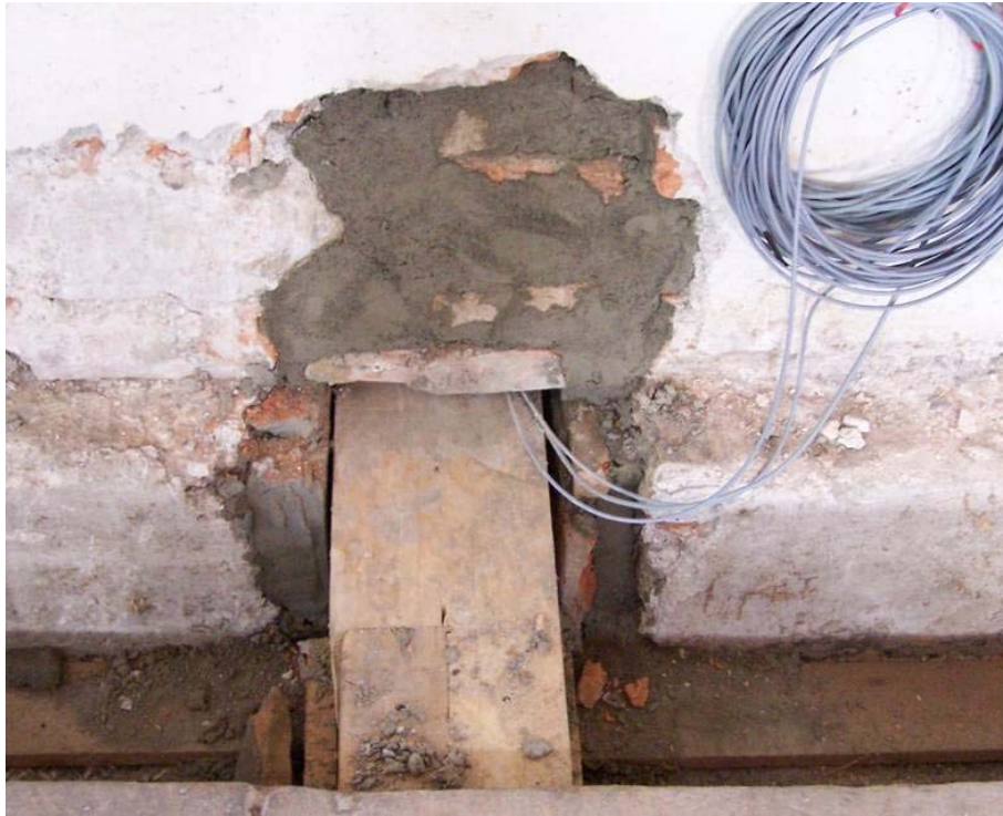
Abb. 53 Einbausituation der Variante N5/3 mit viel Mörtel am Balkenkopf.
