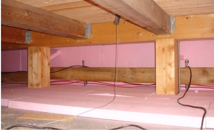
Abb. 69 Unbeheizter Luftraum oberhalb der Holzbalkendecke mit Tragkonstruktion für das auf der Attika montierte Flachdach.
