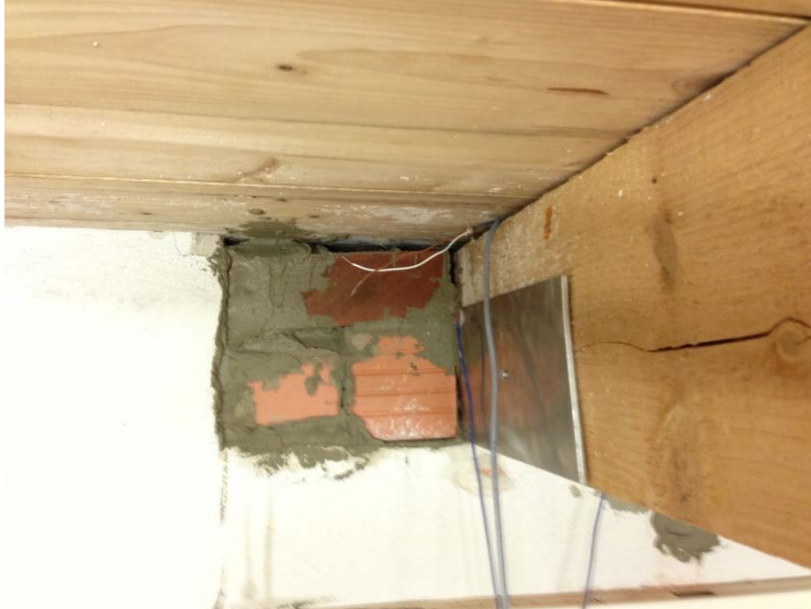
Abb. 72 Ansicht der Ausführung des Balkens 1 im Raum 1 mit „Aluminiumblech“.
