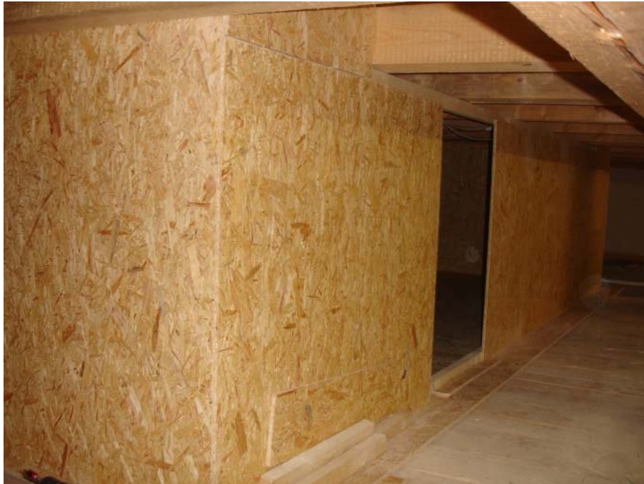
Abb. 71 Ansicht der fertigen Trennwand eines Messraumes mit einer durch ein OSB-Plattenstück verschließbaren Schlupföffnung
