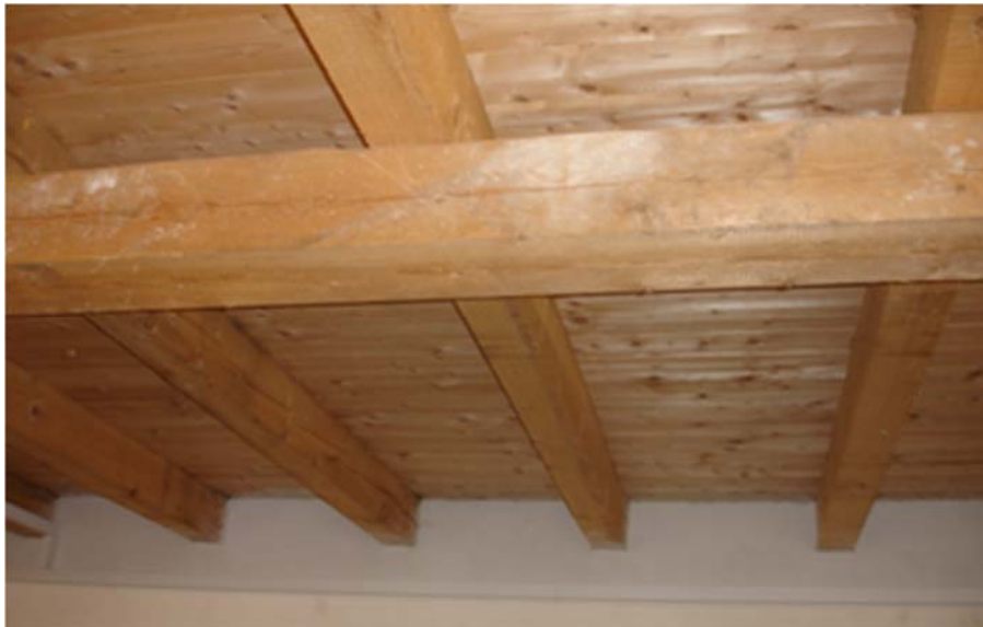
Abb. 68 Ansicht der Unterseite der Holzbalkendecke vor dem Einbau der Messräume und der Sensorik.
