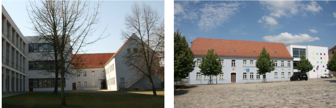
Abb. 10 Schulgebäude Drebkau – Bild links: Nordostfassade, Bild rechts: Südwestfassade.
