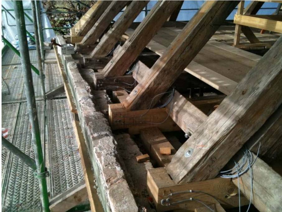
Abb. 42 Ansicht der Balkenköpfe auf der Südseite mit seitlich angebrachten Messschrauben zur Ermittlung der Holzfeuchten im oberflächennahen Bereich und im Balkenkopfkern, an neu sanierten und an alten unsanierten Balkenköpfen.
