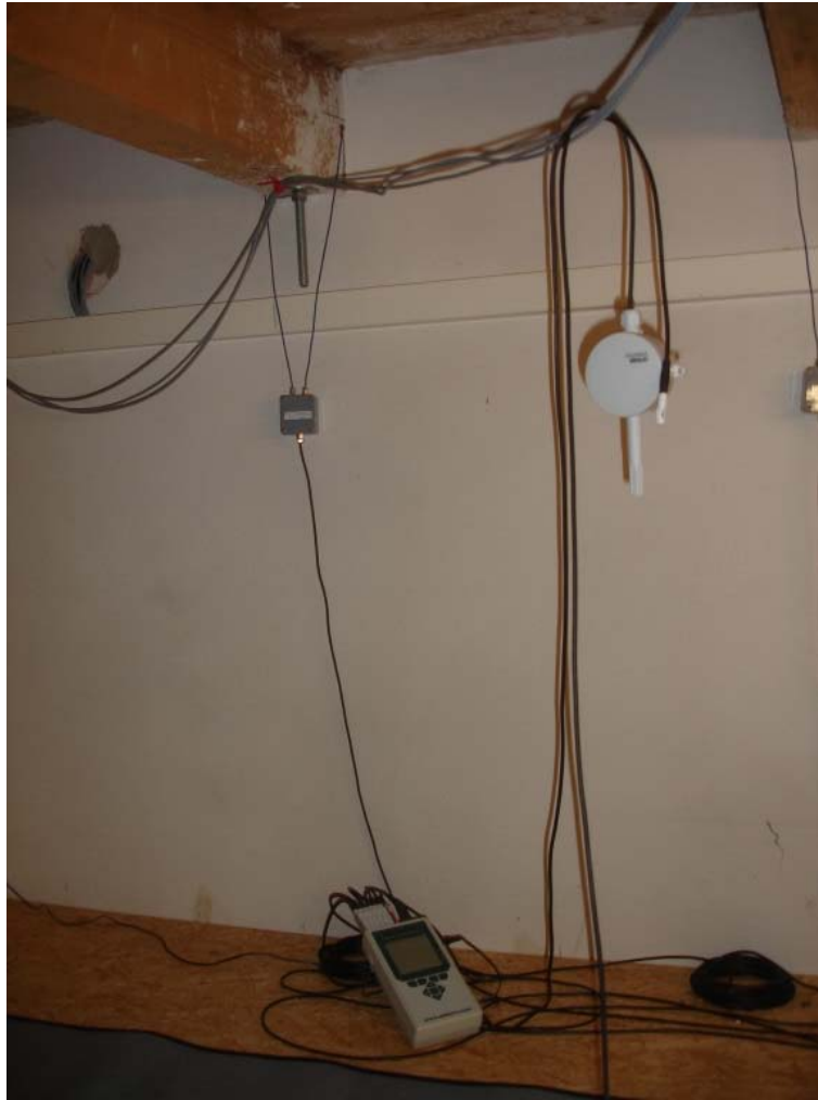
Abb. 80 Ansicht des Datenloggers (unten), eines Holzfeuchtemessmoduls (oben links) sowie der Mess- und Steuereinheit für die Herstellung der Feuchtelast (oben rechts) im Raum 1.
