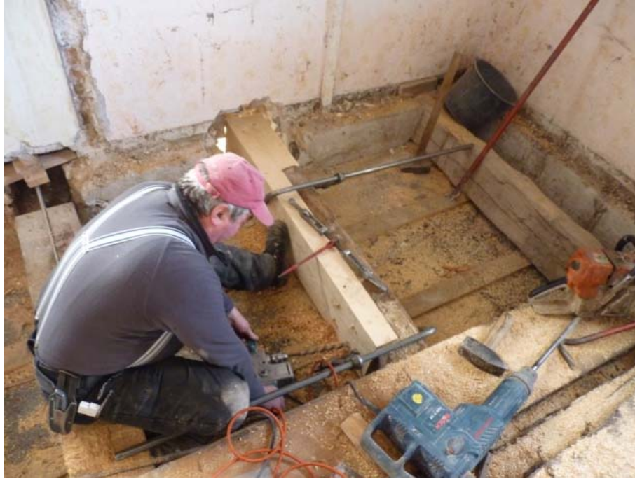
Abb. 25 Arbeiten zur Überblattung des alten Holzbalkens.
