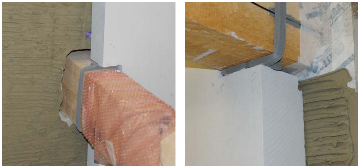
Abb. 114 Abdichtungsvarianten der Balkenkopftasche in Prüffeld 2.
