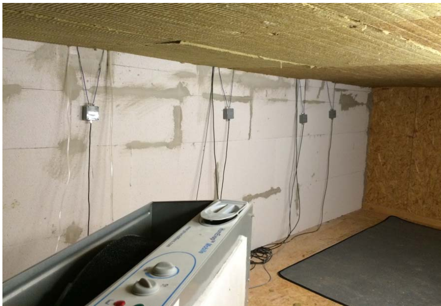
Abb. 83 Blick in Raum 1 mit an der Außenwand angebrachter Innendämmung und Beplankung der Holzbalkendecke mit 2 cm starken Mineralwolleplatten.
