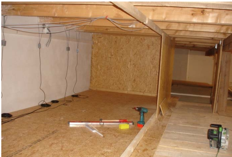
Abb. 70 Beginn der Erstellung der Messräume aus Holzwerkstoffplatten (OSB) im Winter 2013.
