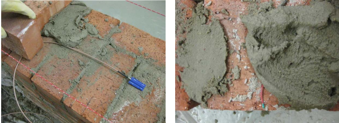
Abb. 108 Links kombinierter Sensor für Temperatur und relative Luftfeuchte mit Schutzkappe und rechts Temperatursensor nahe der Kaltseitenoberfläche.
