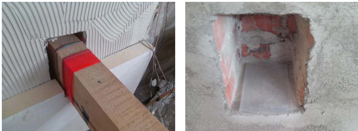
Abb. 111 Links Ausführung einer doppelten Abdichtungsebene und rechts der hygrischen Entkopplung in Feld 1. Rechts ist ebenfalls der kombinierte Sensor für Temperatur und relative Luftfeuchte in der Lagerfuge zu erkennen.
