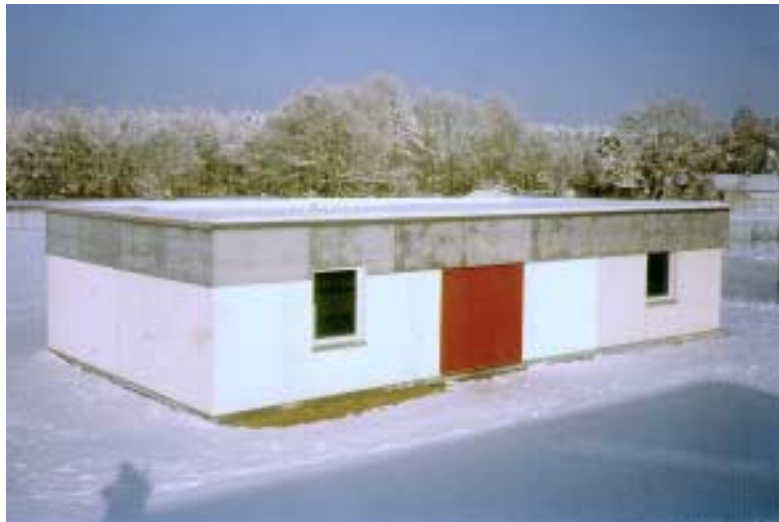
Bild 5: Westfassade mit WDVS (links) und Südfassade in der Mitte mit weiß und rot gestrichenen monolithischen Außenwänden des HAMTIE-Testhauses
