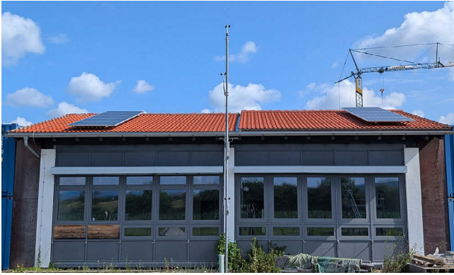
Bild 2 Fertiger Versuchsaufbau; linke Dachhälfte: Konstruktion B, rechte Dachhälfte: Konstruktion B2 (Quelle: Kölsch/Fraunhofer IBP) Completed test setup; left half of roof: design B, right half: design B2
