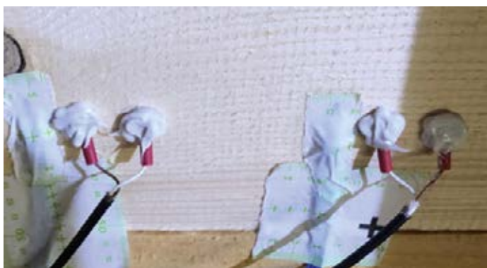
Abb. 3: Fertige Widerstands- und Temperaturmessstellen in einem Schalungsbrett der Dachkonstruktion. Links für die Handmessung, rechts für die automatische Messung.
