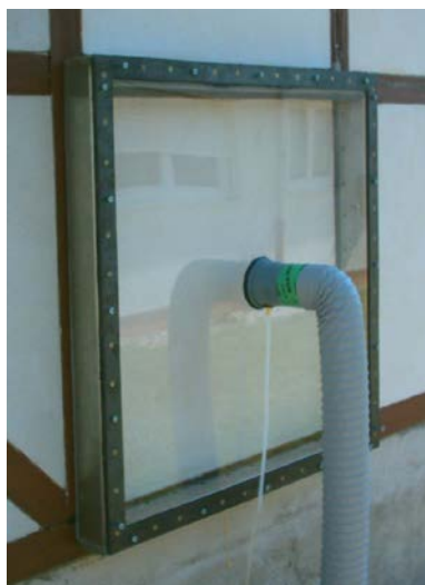
Bild 6: Die Messmaske zur Ermittlung der Luftdichtheit der Gefachaufbauten im Montagezustand.
