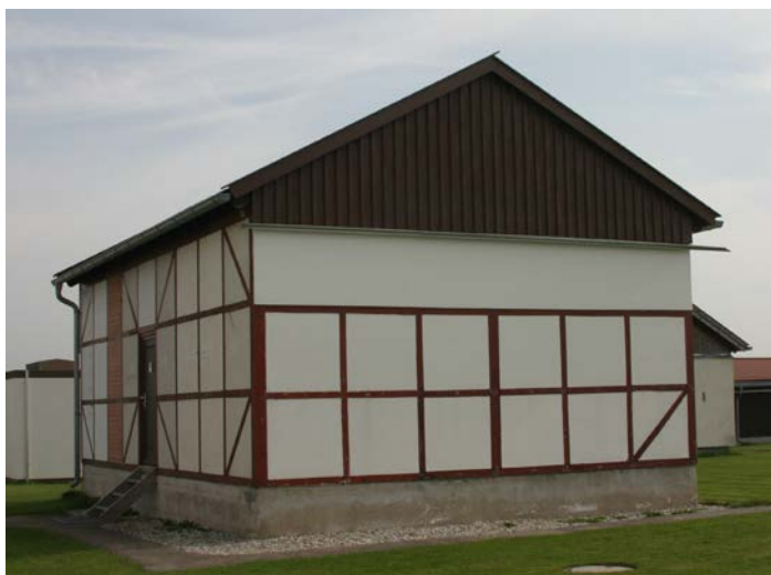
Bild 1: Westansicht des Versuchsfachwerkhauses nach dem Umbau
