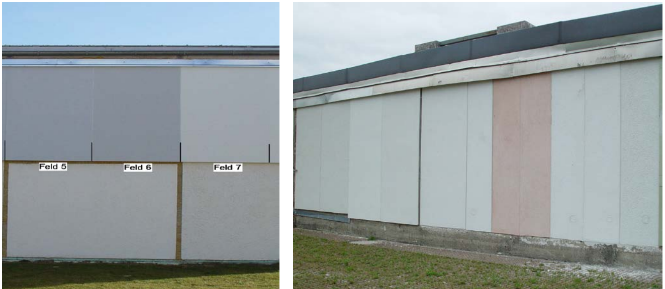
Bild 3: Fotografische Ansicht der westorientierten (rechts) und nordorientierten (links) Fassaden.
