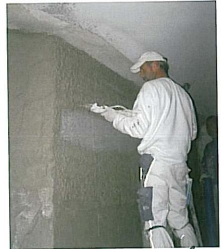
Abb. 10: Fotografische Aufnahmen während der Applikation der Zellulosedämmung
