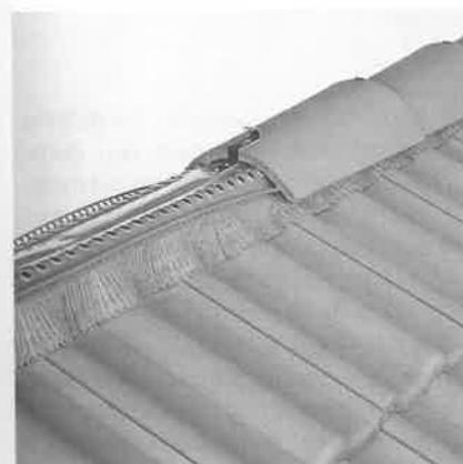
Bild 9 a: Firstausbildung bei Dachdeckungen mit Betondachsteinen.
