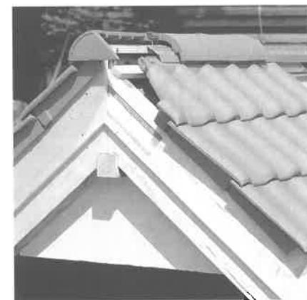
Bild 9 b: Firstausbildung bei Dachdeckungen mit Ziegeln.
