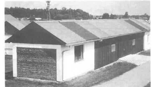
**Bild 7:** Ansicht des Versuchsbäudes mit steilgeneigten Dachflächen (50°), nach Osten und Westen orientiert, hier mit Betondachsteinen ohne und mit Unterlüftung gedeckt.
