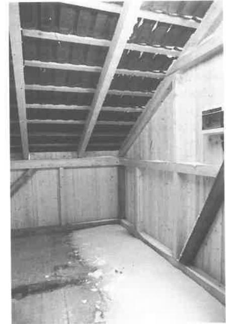
**Bild 14:** Blick auf die nach Westen geneigte Dachfläche eines unbeheizten Versuchsraumes ohne Dachdämmung. Bei starkem Wind und infolge Durchströmung des nichtausgebauten Dachraumes reicherte sich in einer wind- und schneereichen Periode Flugschnee im Raum an.
