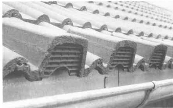
**Bild 10:** Zur Verstärkung der Belüftung der oberen Luftschicht im Traufbereich eingesetzte Lüftersteine (Untersuchungsperiode 1988).
