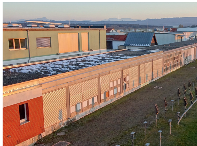
Abb. 1: Klimatisierte Versuchshalle des Fraunhoferinstituts für Bauphysik in Holzkirchen
