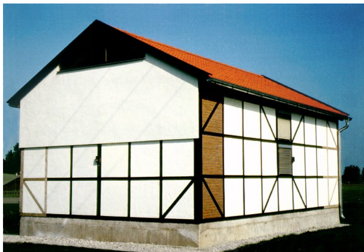
Bild 1 Fotografische Aufnahme des Fachwerkhauses auf dem Freigelände des Fraunhofer-Instituts für Bauphysik in Holzkirchen.
